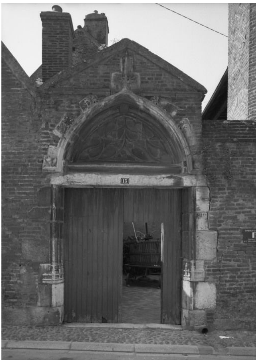
Portail de la cour intérieure.
