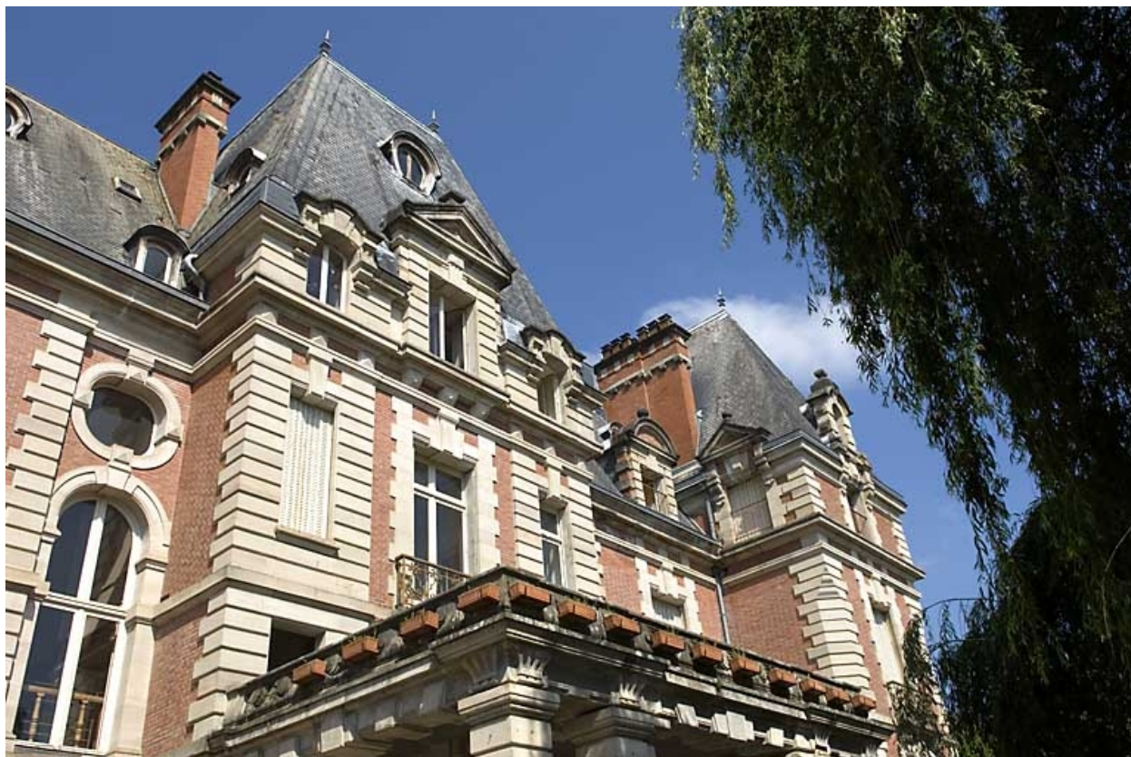
Logement patronal. Détail de la façade antérieure.
