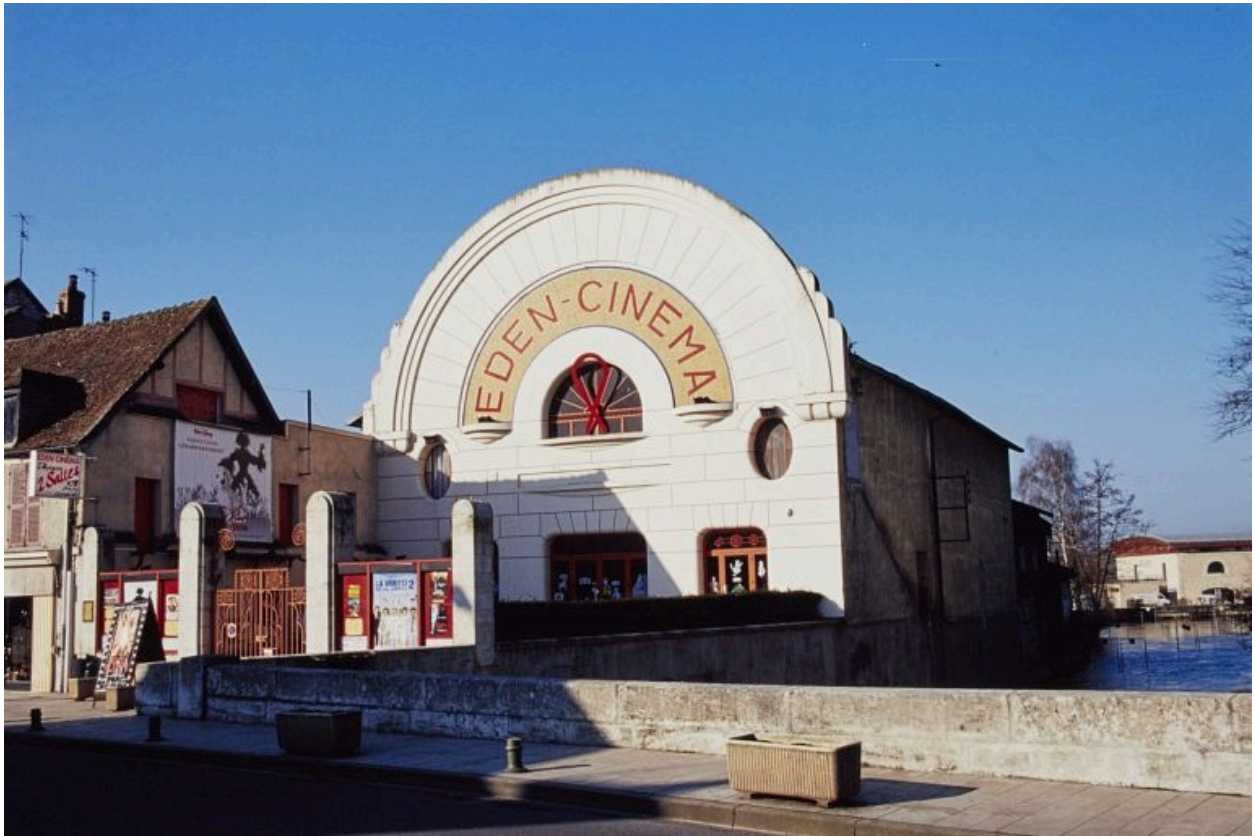
Elévation principale, vue d'ensemble, en 2001.
