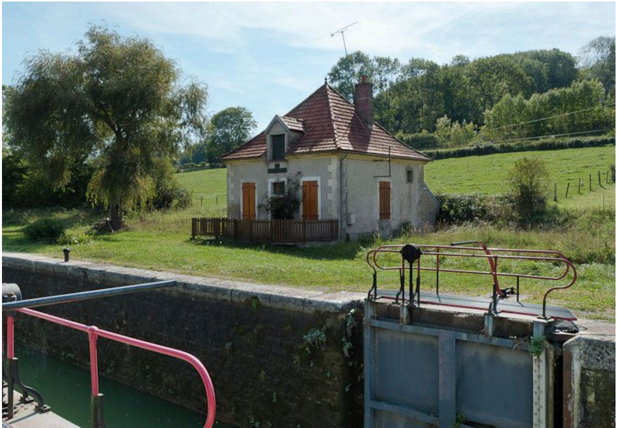
Vue d'ensemble du site d'écluse.
