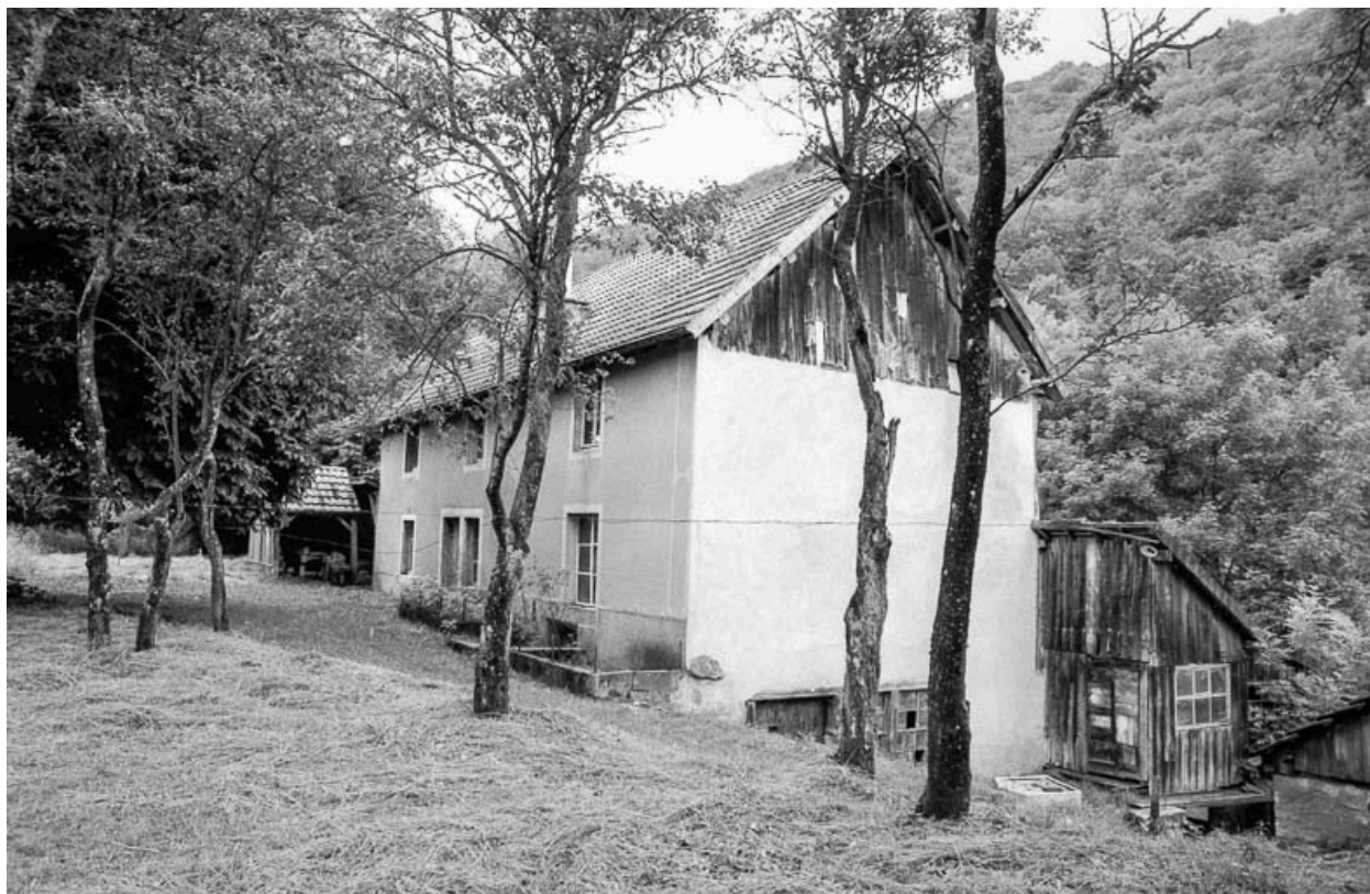
Vue d'ensemble depuis le sud-est en 1980.
