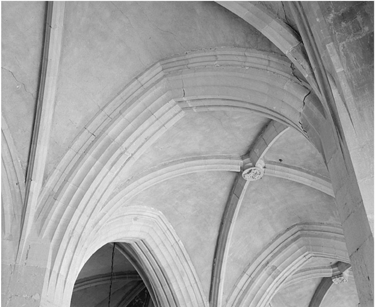
Voûte de la cinquième travée du collatéral nord depuis l'est.
