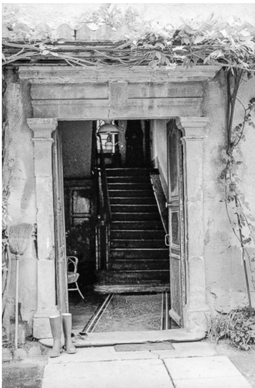
Façade antérieure : porte d'entrée.
