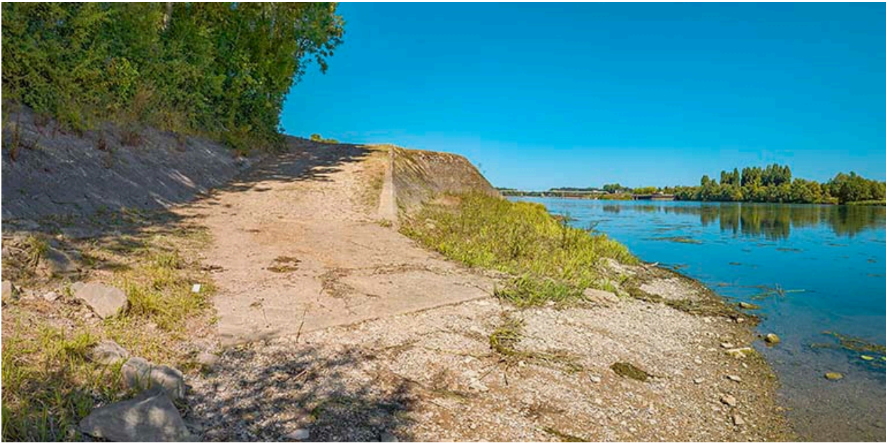
Rampe et perrés de la Mare-Jandeau.
