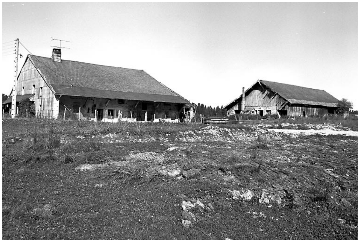
Vue d'ensemble de la ferme et de la dépendance.
