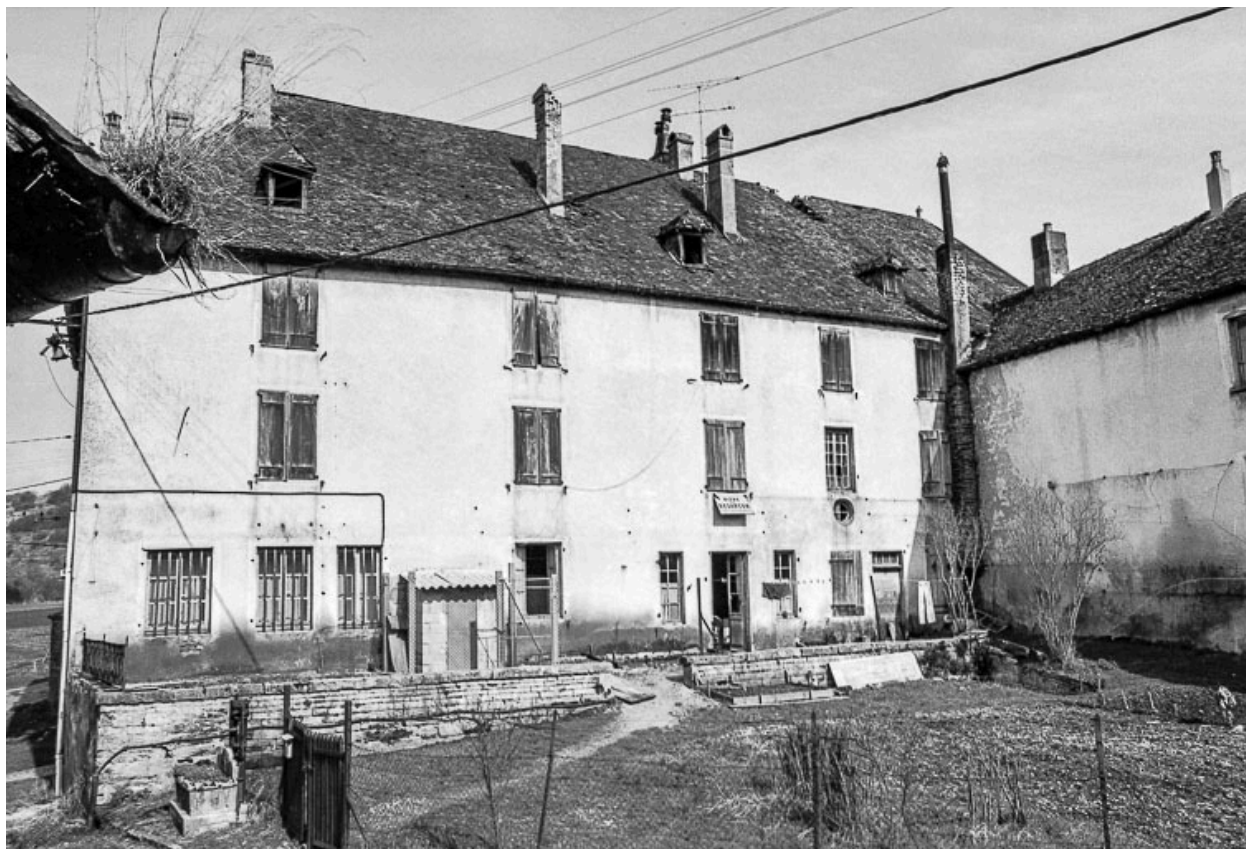
Logement ouvrier, bureau et dispensaire en 1979.
