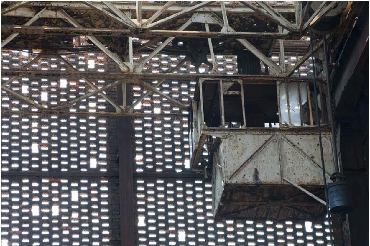
Bâtiment du gazogène. Cabine du pont roulant.
