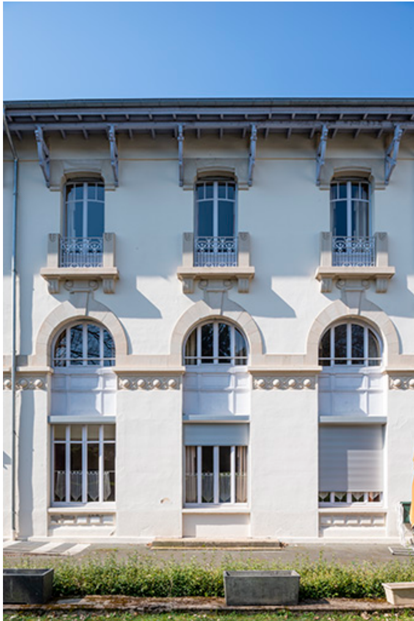
Façade est, vue de face, détail.
