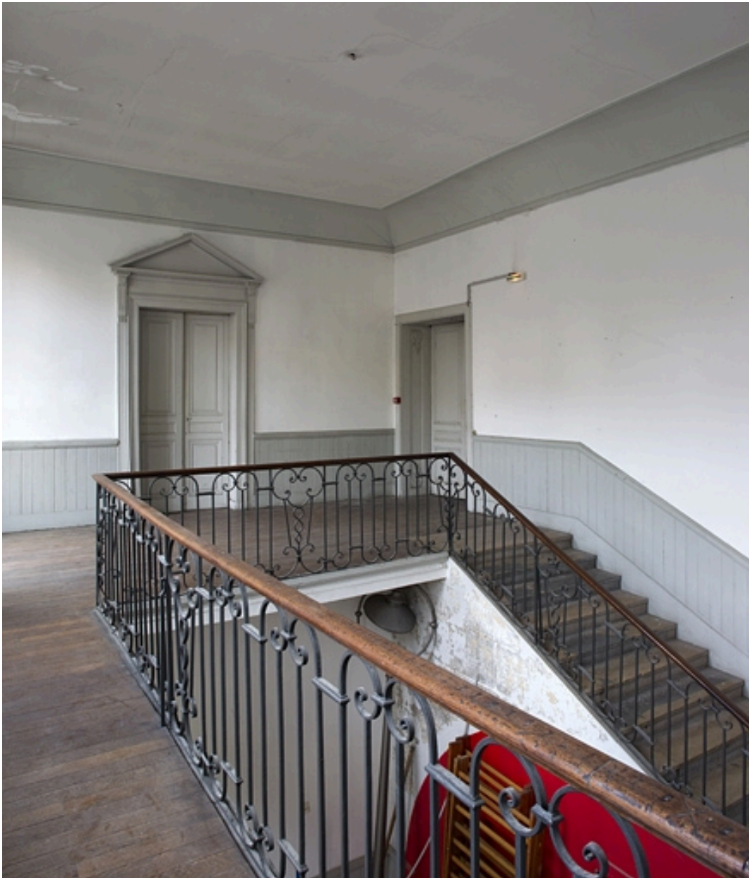
Logis principal, intérieur : vue d'ensemble de l'escalier.
