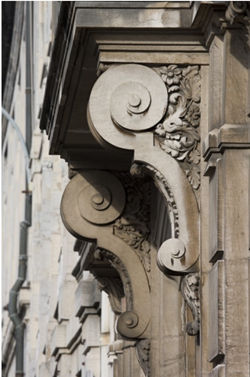
Détail des supports en forme de volutes soutenant le balcon du premier étage.
