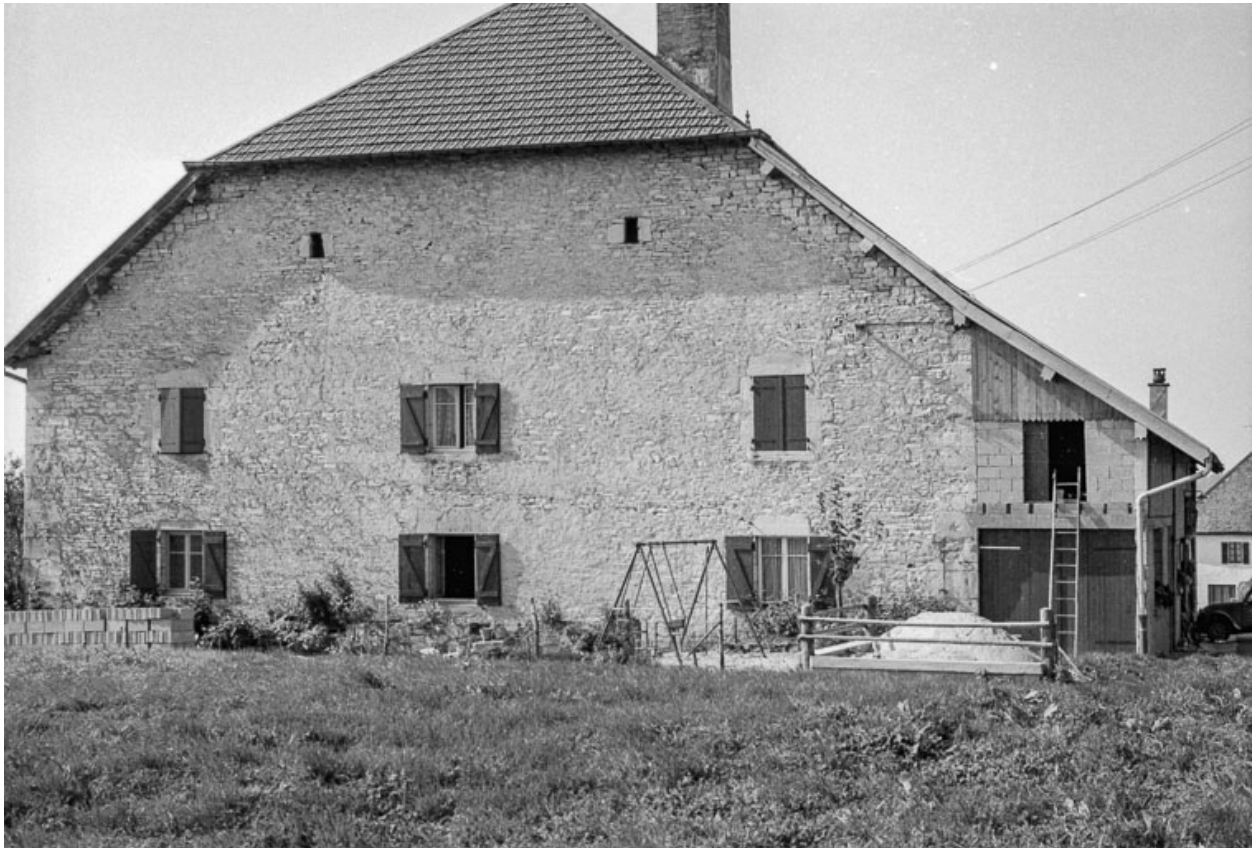
Ferme cadastrée 1961 AB 42 : façade antérieure.
