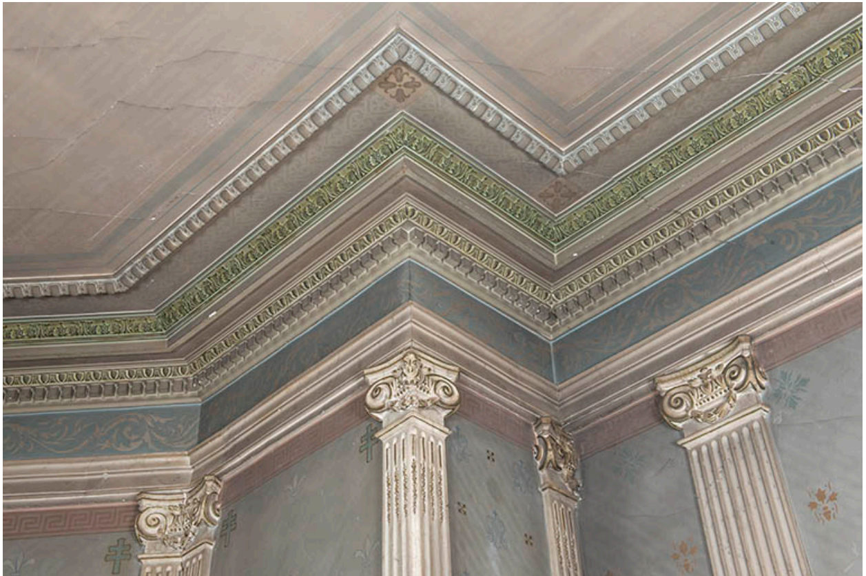
Détail des corniches du chœur.
