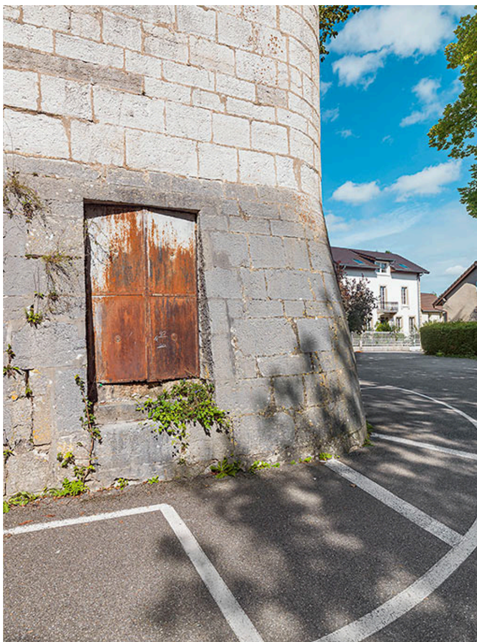
Poterne du demi-bastion.
