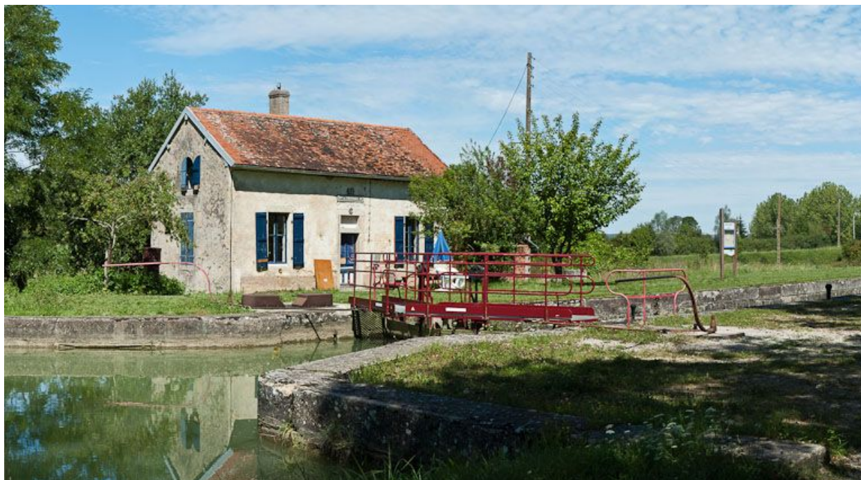
Vue d'ensemble du site d'écluse.
