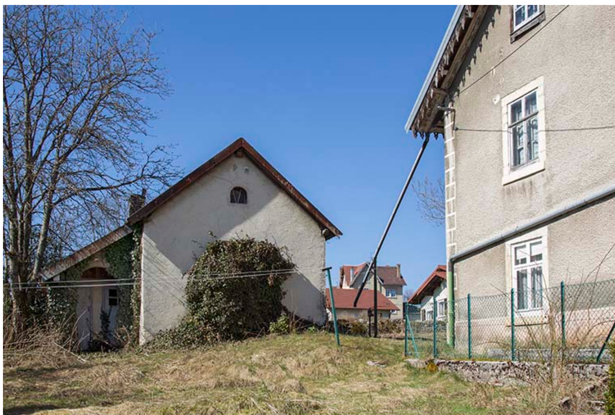
Tuyau d'alimentation de la citerne et dépendance.
