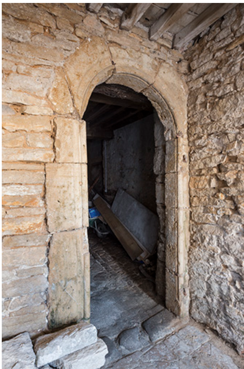
Porte d'accès à la grange, rez-de-chaussée.
