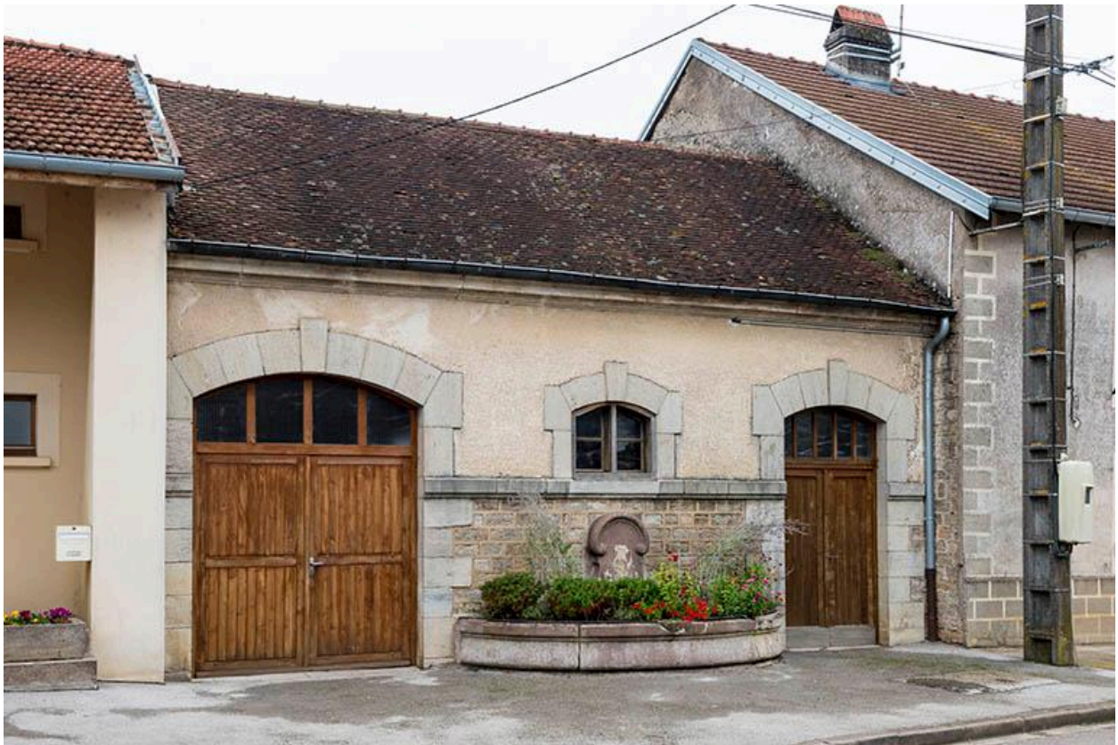
Façade sur rue de la remise de matériel d'incendie et du lavoir appelé "La Bichette", rue des Vignes.
