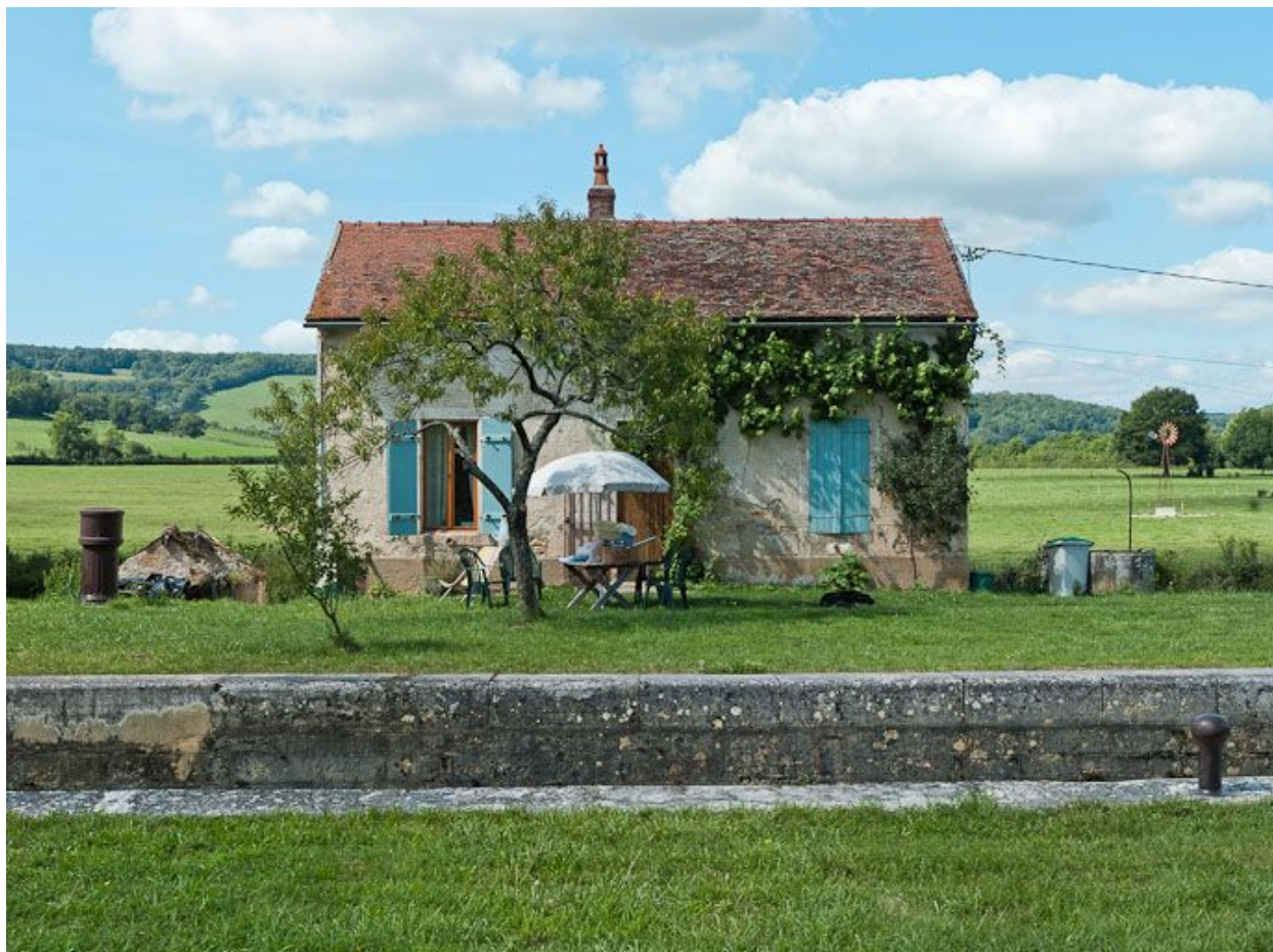
Vue de face de la maison éclusière.
