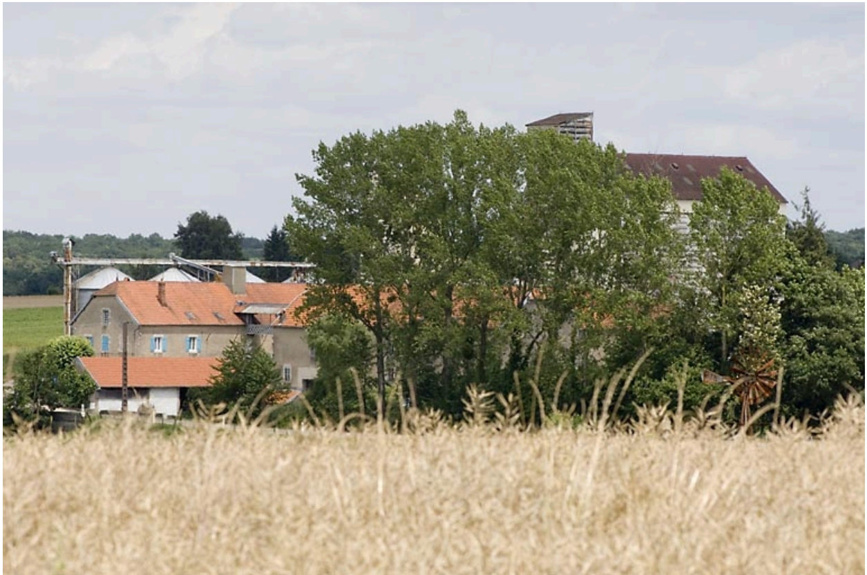
Vue rapprochée depuis le sud-ouest.
