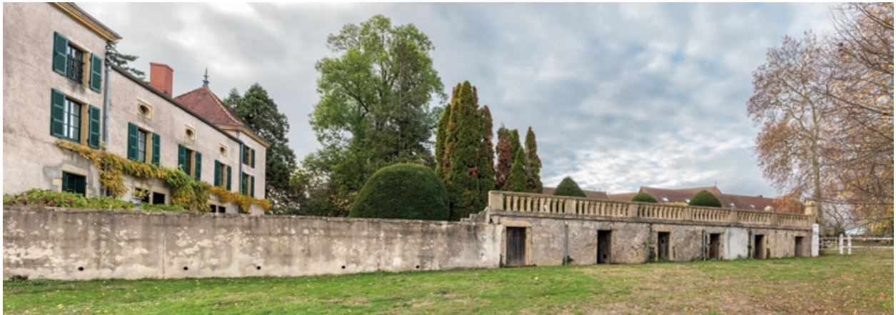
Vue du château, du mur de soutènement de la cour et des chenils
