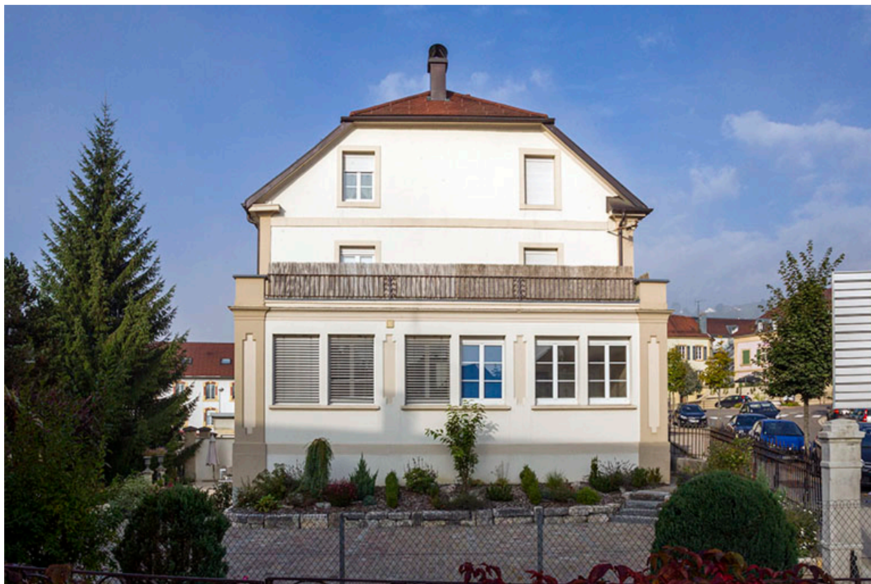
Façade latérale gauche, avec l'atelier.
