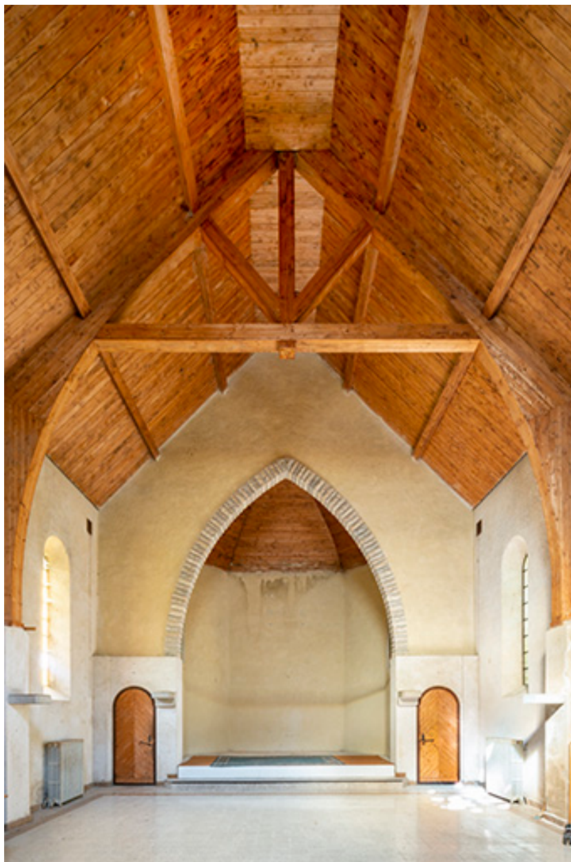
Vue intérieure, depuis l'est.
