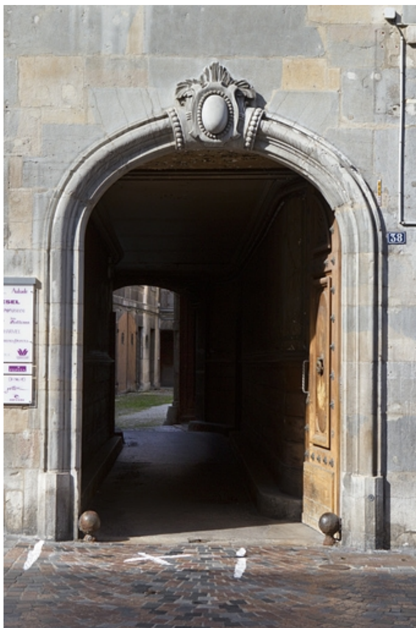
Détail du portail d'entrée.
