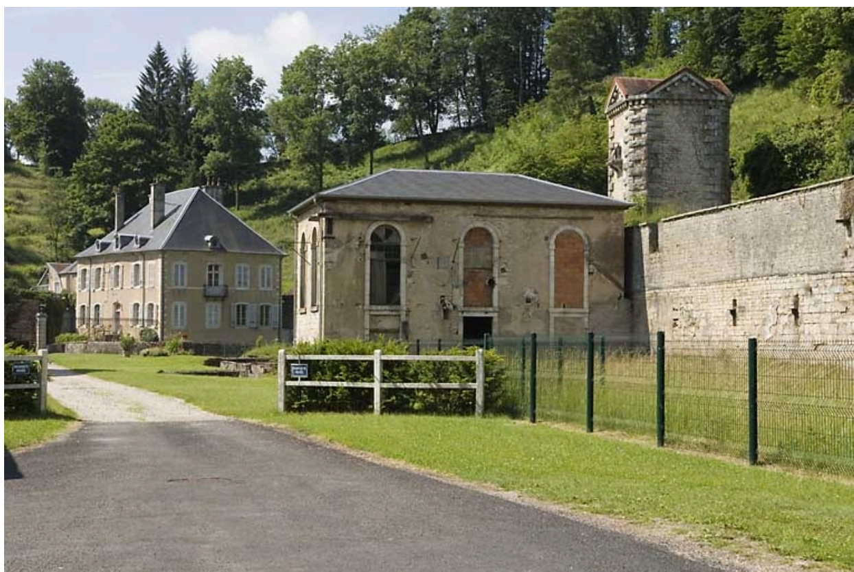
Logement patronal, salle des machines et pigeonnier depuis le nord-ouest.
