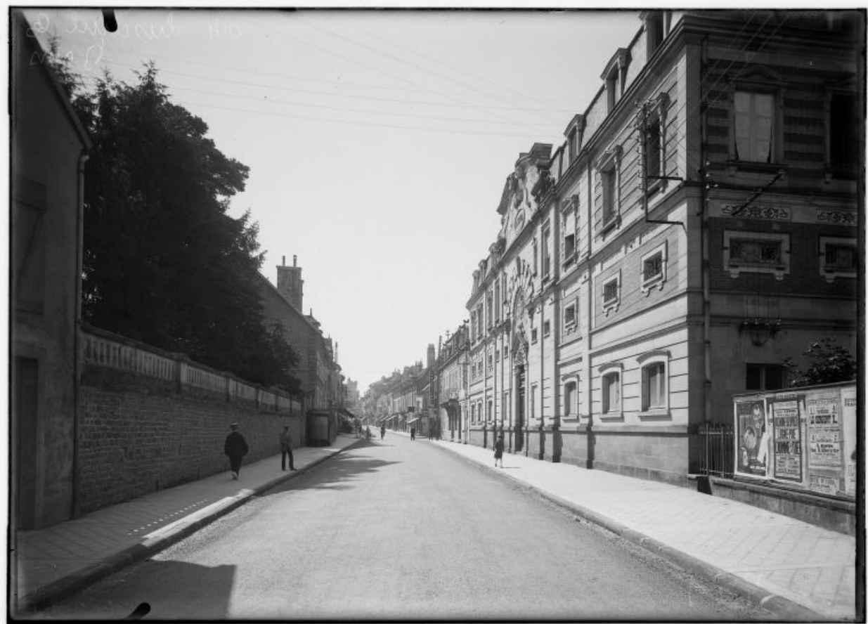
Façade sur la rue de Grammont, vue prise depuis le nord.
