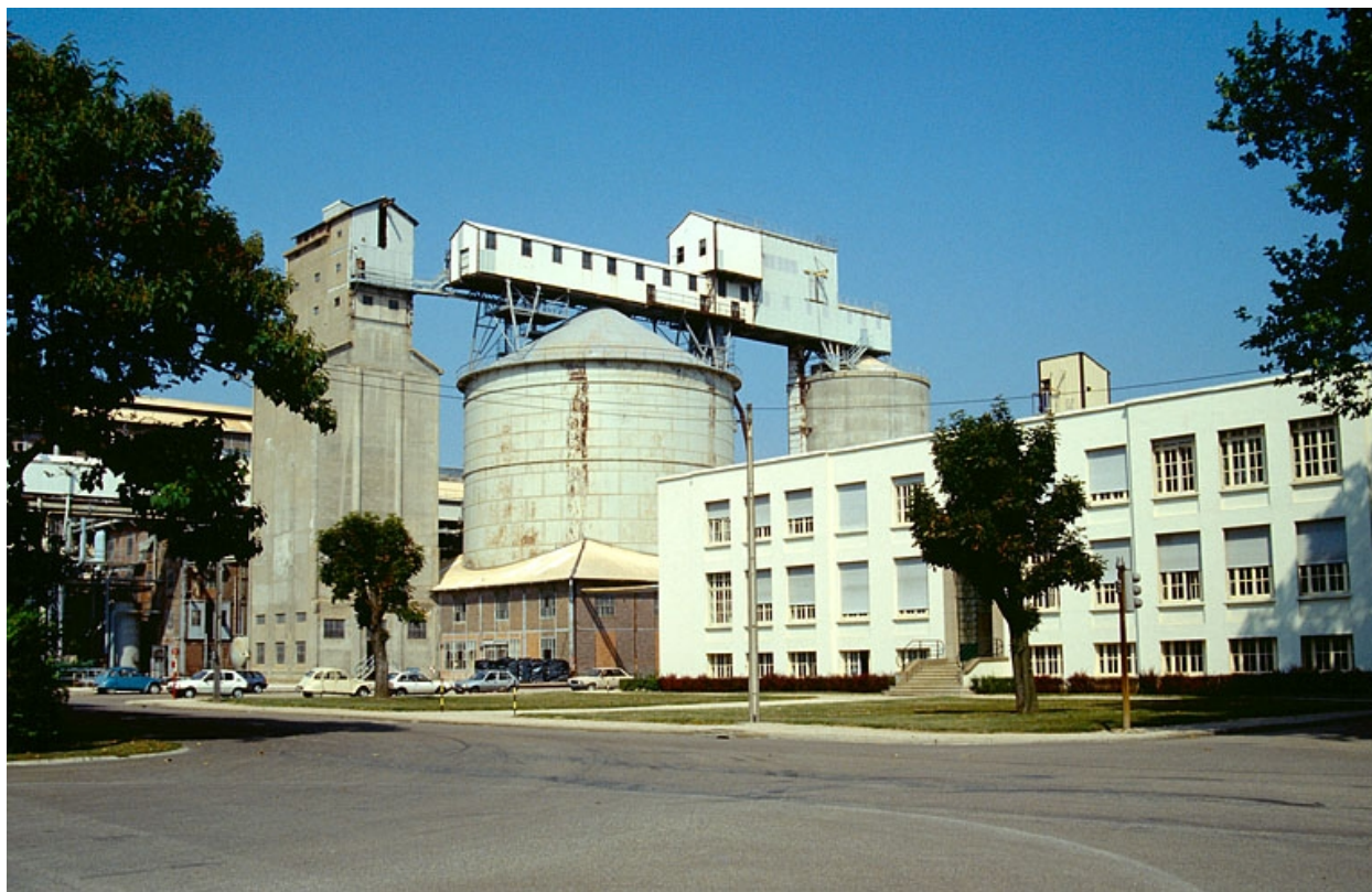
Caisses à soude (13) et laboratoire (14).
