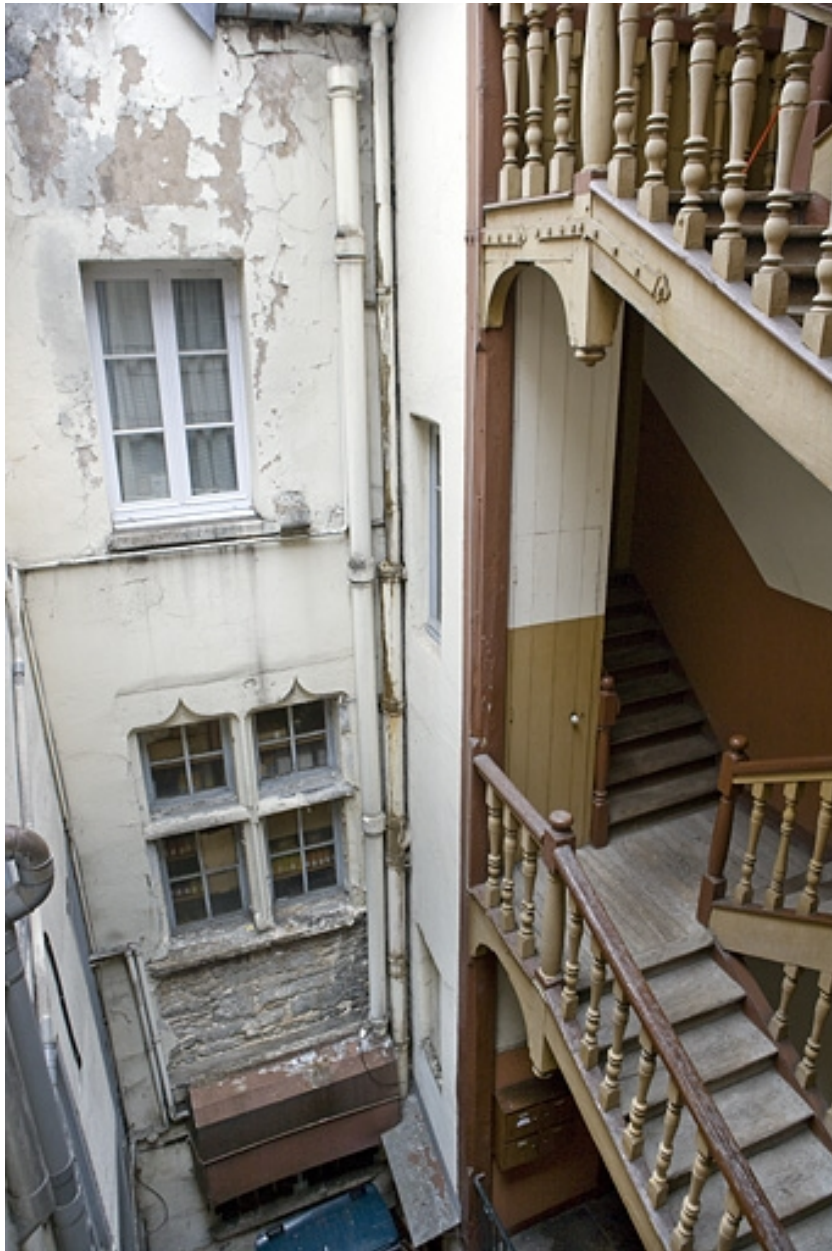
Façade sur cour du logis secondaire depuis l'escalier à cage ouverte.
