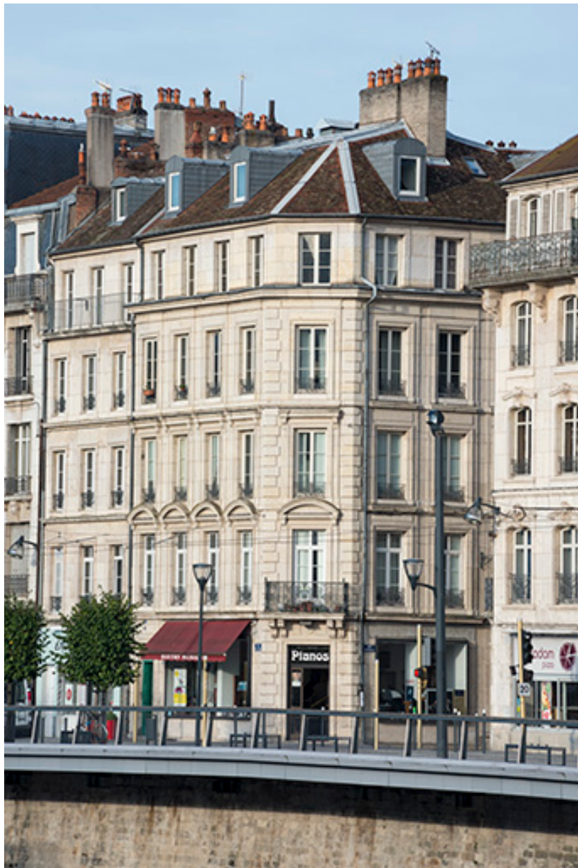
Vue éloignée depuis l'est.
