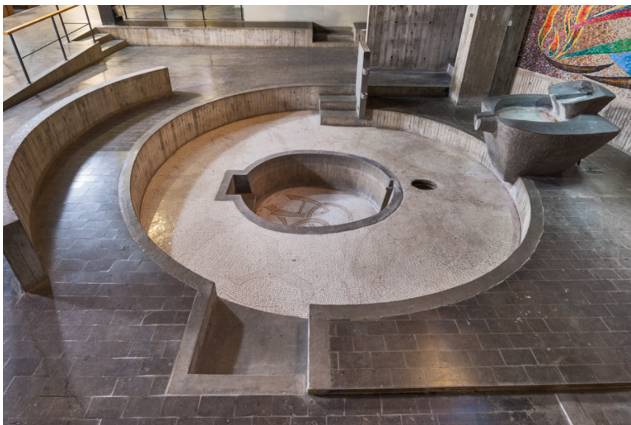
Piscine et fontaine baptismales. Vue de côté.
