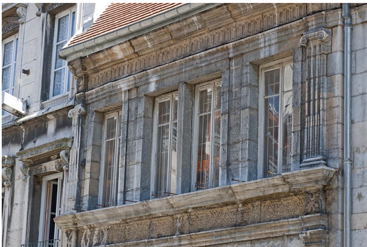
Façade sur rue : premier étage, partie gauche.
