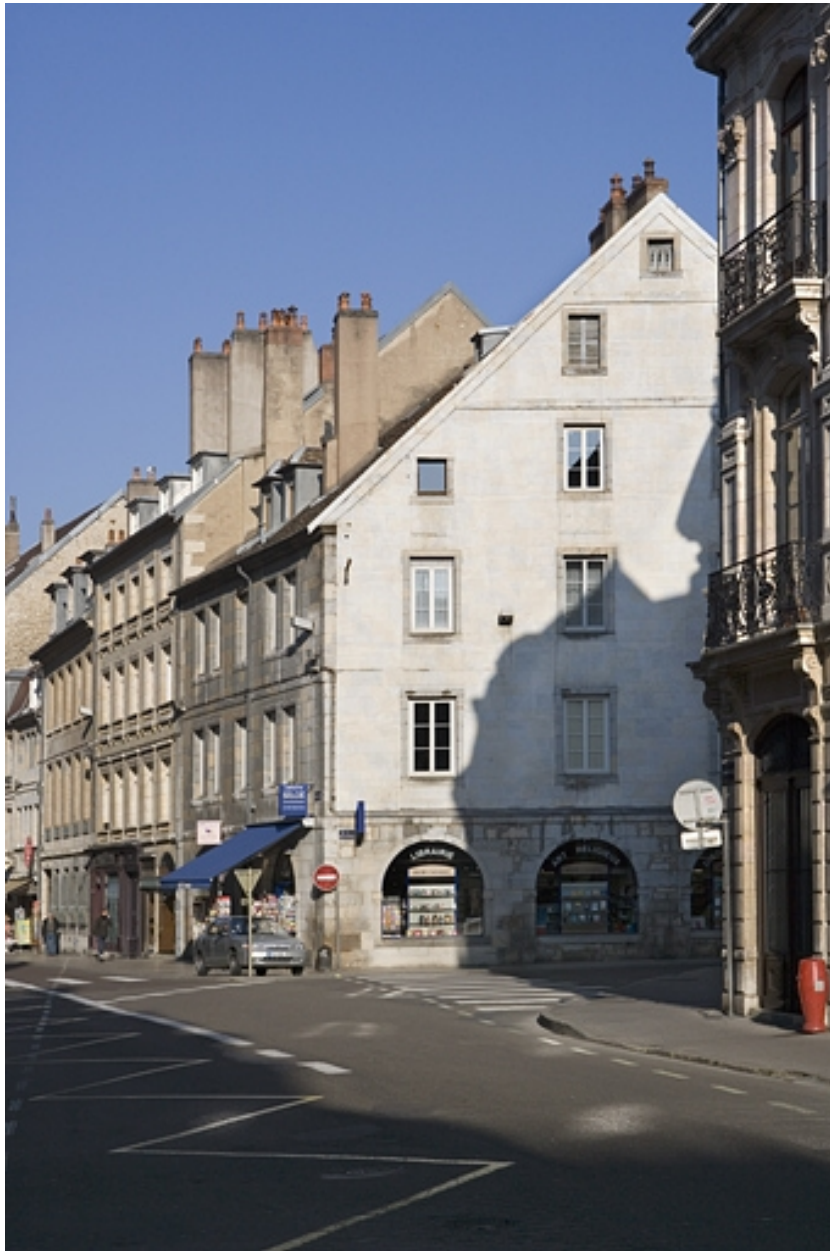
Vue d'ensemble du logis principal de trois quarts droit.
