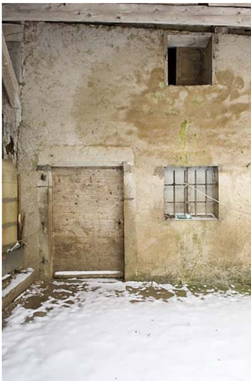
Façade postérieure : porte.
