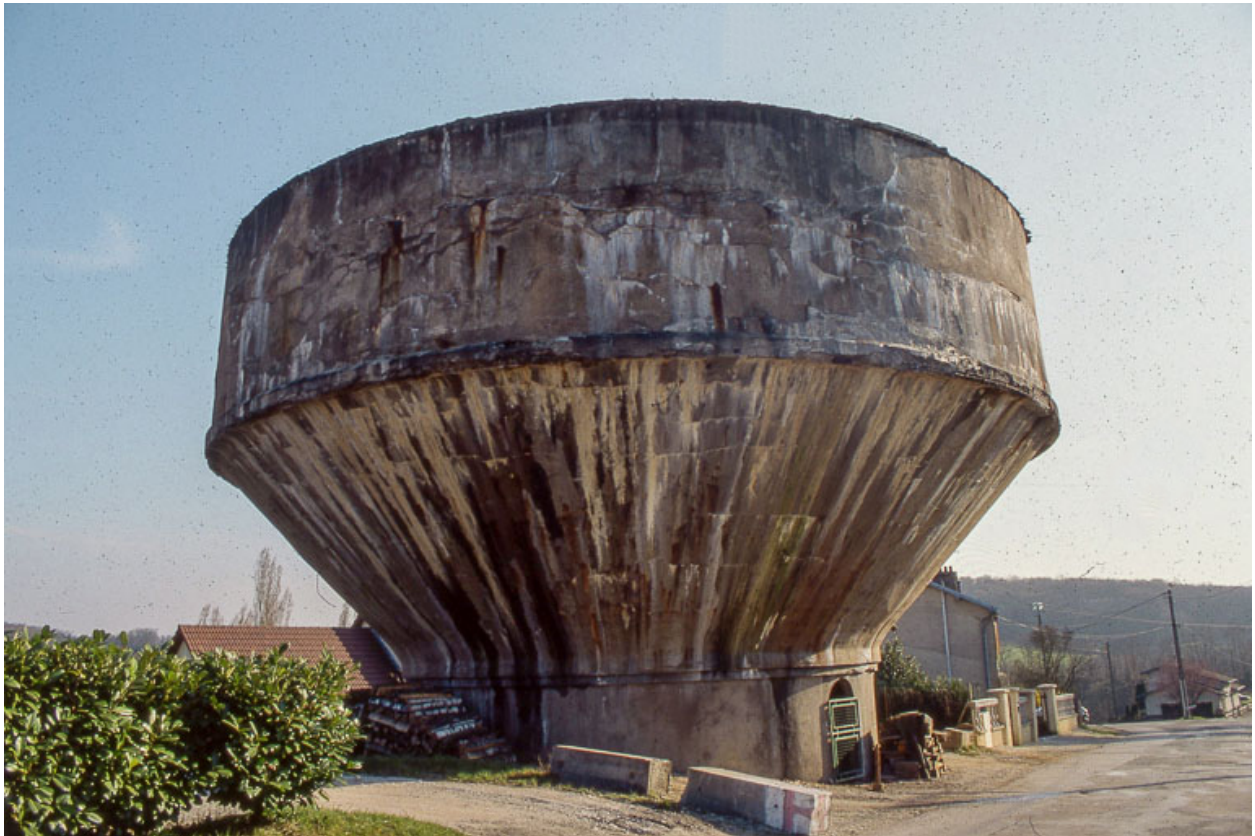
Réservoir industriel (depuis le nord).
