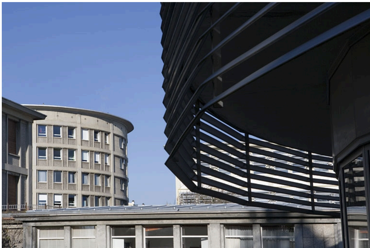
Détail architecture aile gauche bâtiment L.
