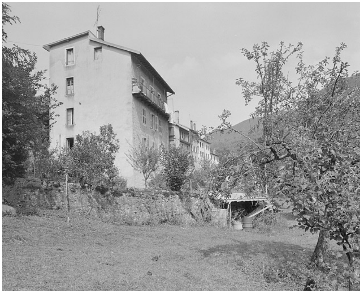
Face droite et façade postérieure.
