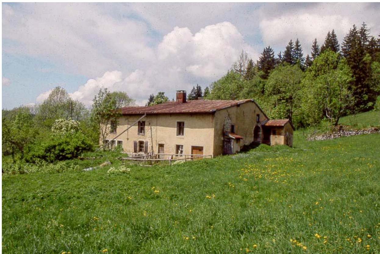
Vue éloignée de la façade antérieure.
