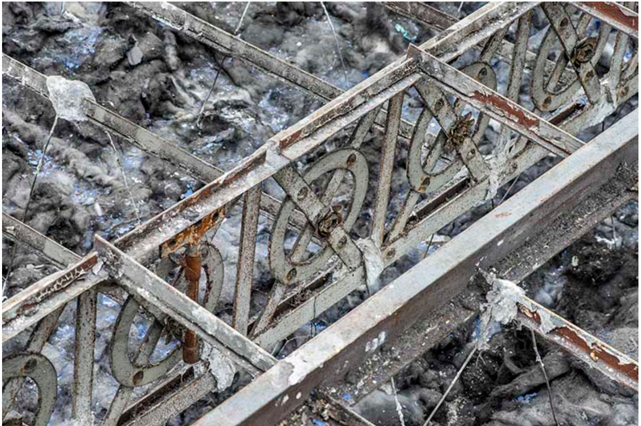
Halle : détail de la charpente métallique.
