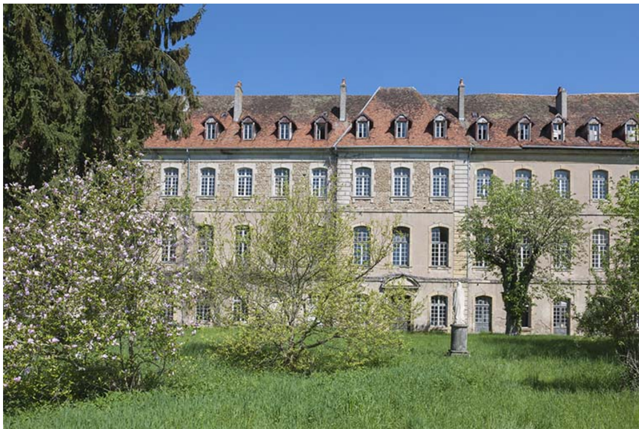
Façade sud vue de face.
