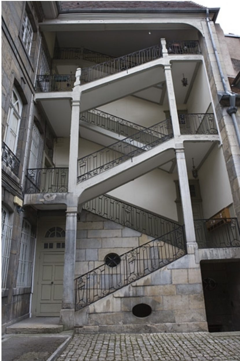
Vue d'ensemble de l'escalier à cage ouverte de face.
