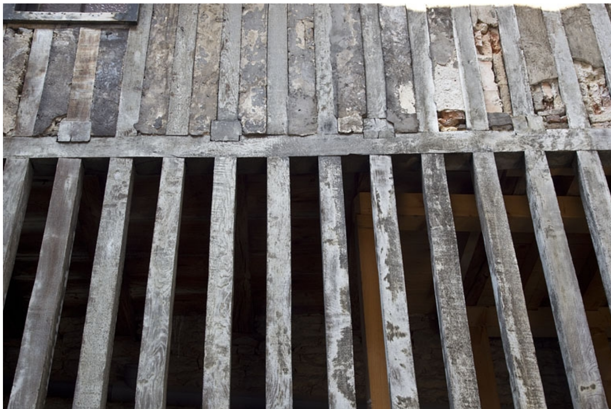
Bûcher : détail des pans de bois.
