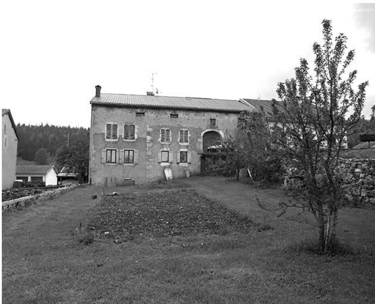
Façade postérieure, vue éloignée.
