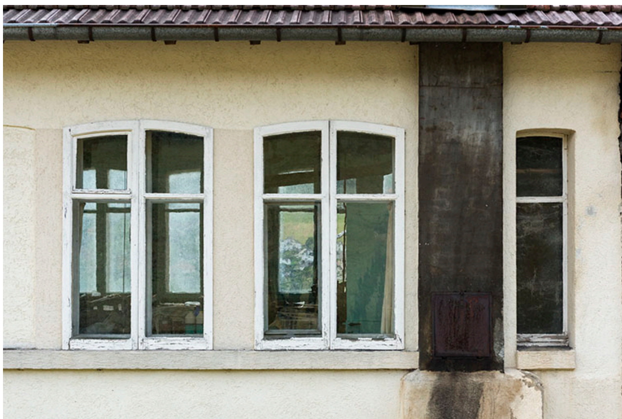
Atelier de fabrication : fenêtre horlogère au nord.
