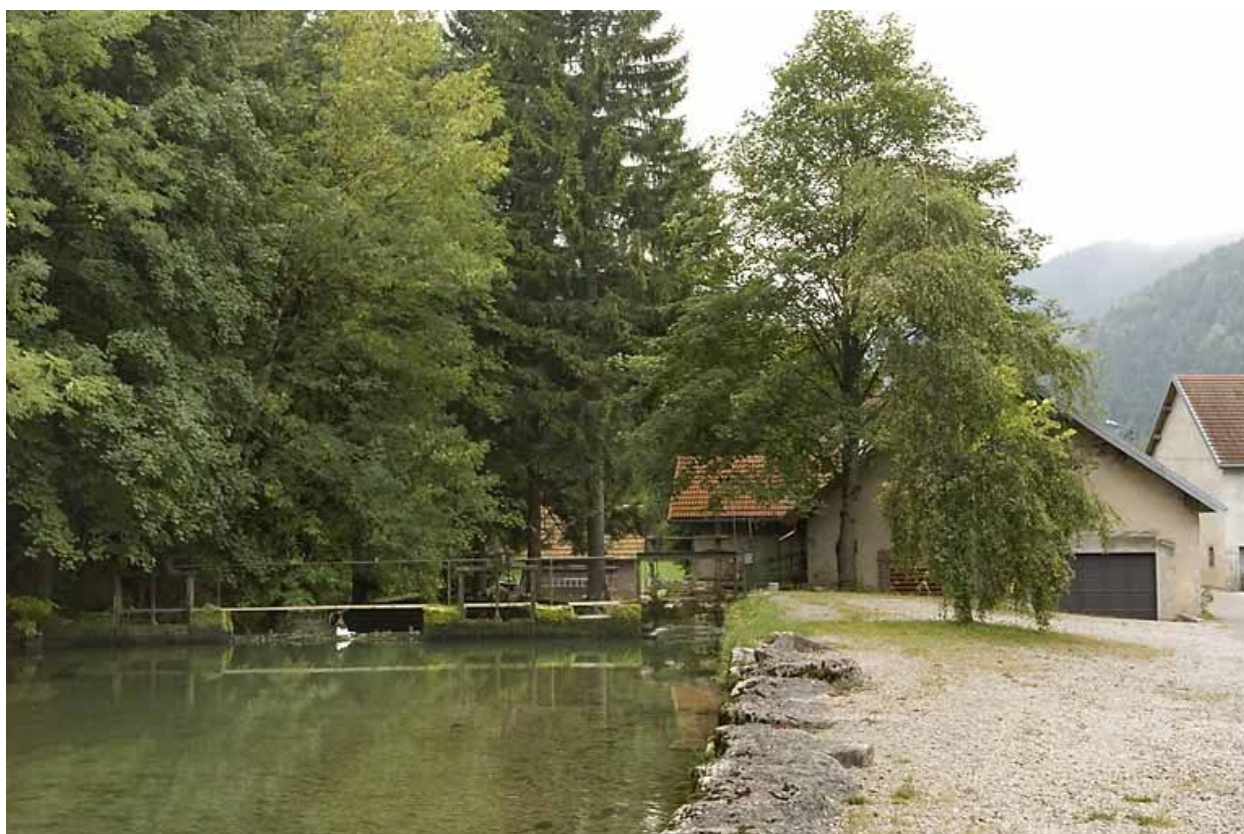
Canal d'amenée, depuis l'amont.
