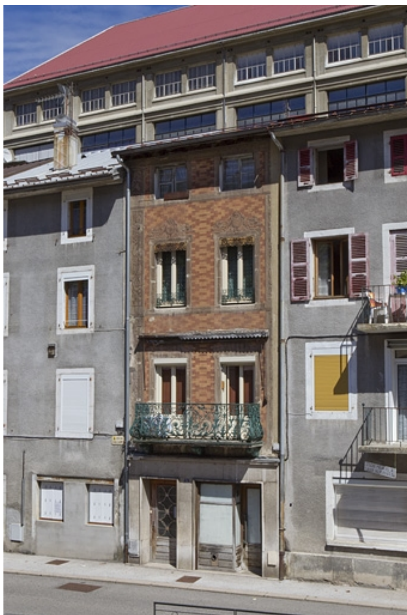
Elévation antérieure, de trois quarts droite.
