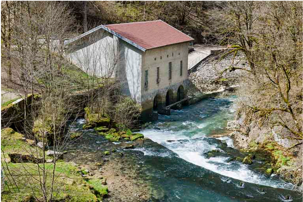
La centrale hydroélectrique depuis l'amont.
