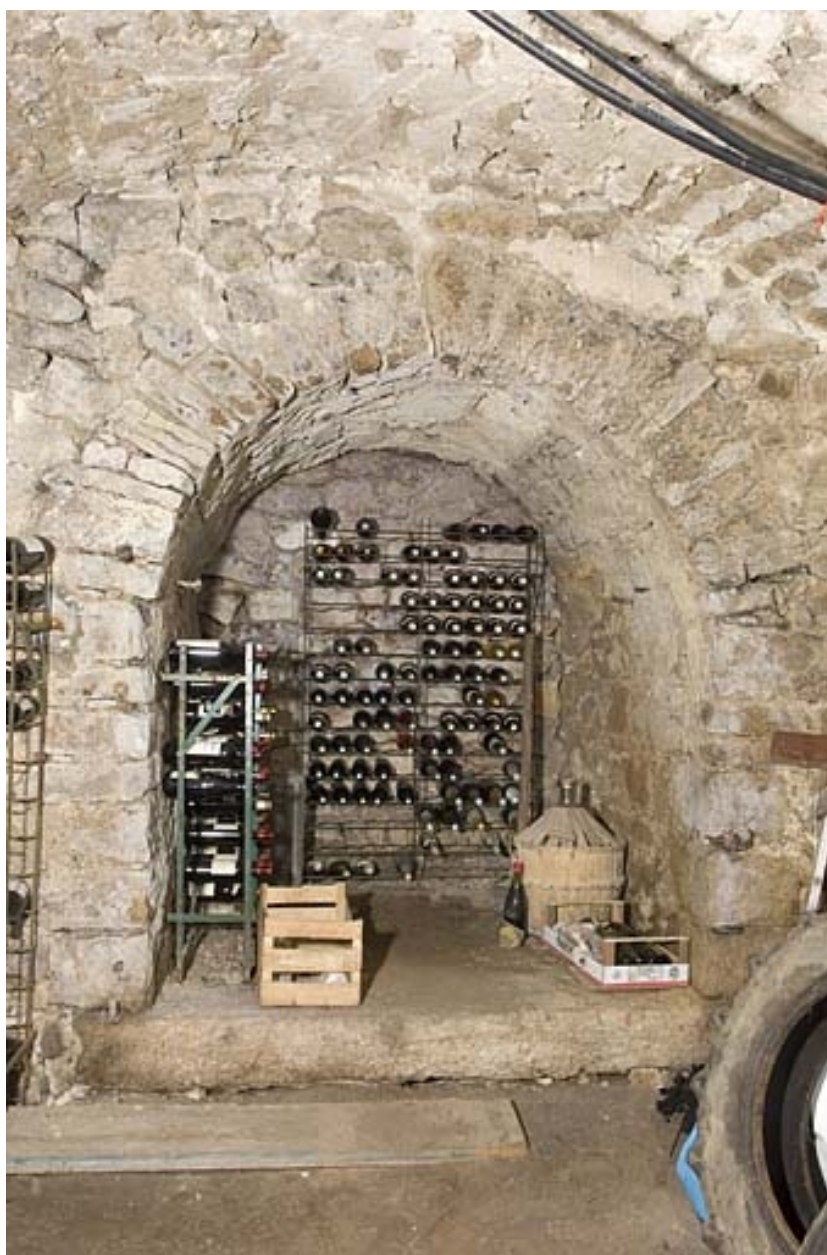
Sous-sol ("cave") : niche.
